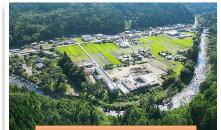
外観（学校林側から撮影）
